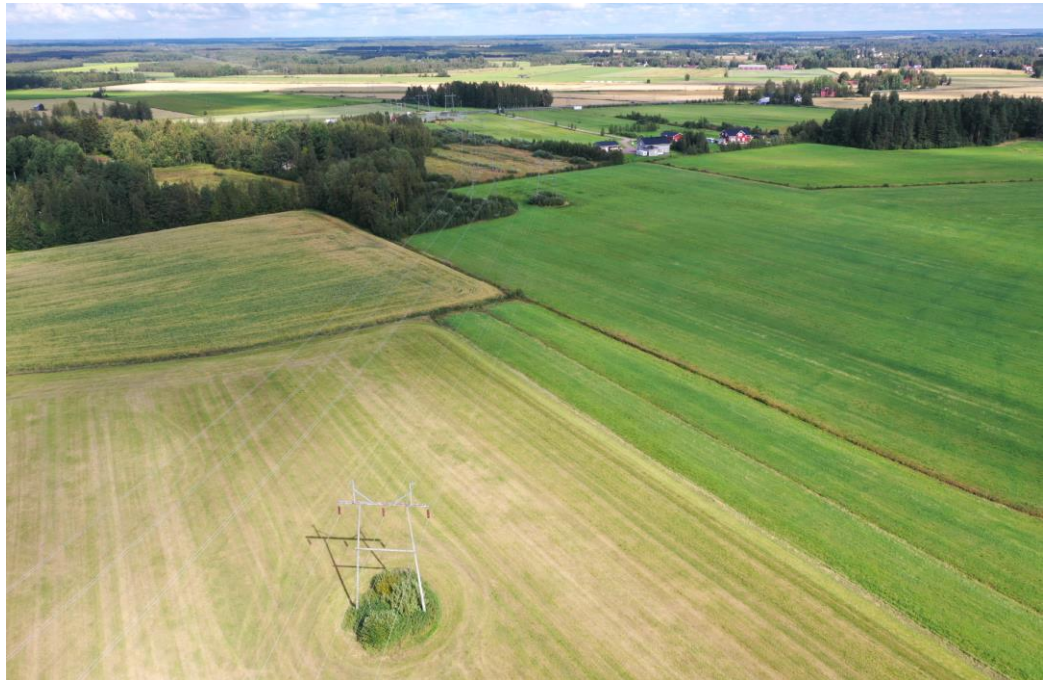
Kuva 4-2. Voimajohto kulkee Limingan maakunnallisesti merkittävän rakennetun kulttuuriympäristön (RKY 1993) lävitse (ilmakuva, Lumijoen eteläpuolinen peltoalue, kuvaussuunta lounas-koillinen).
