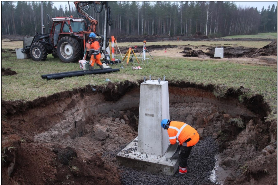
Kuva 3.4. Pylvään perustuselementin asentaminen.
