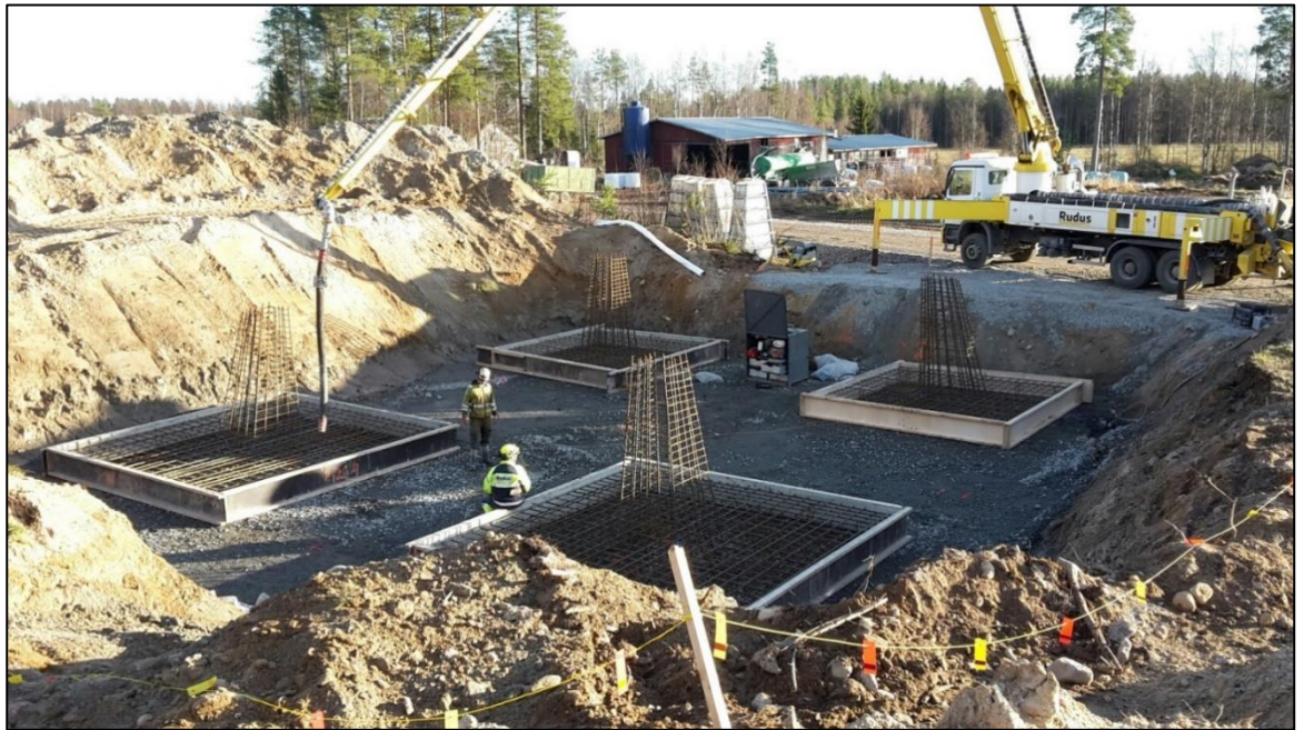
Kuva 3.5. Vapaasti seisovan pylvään perustuksen pohjatöitä.
