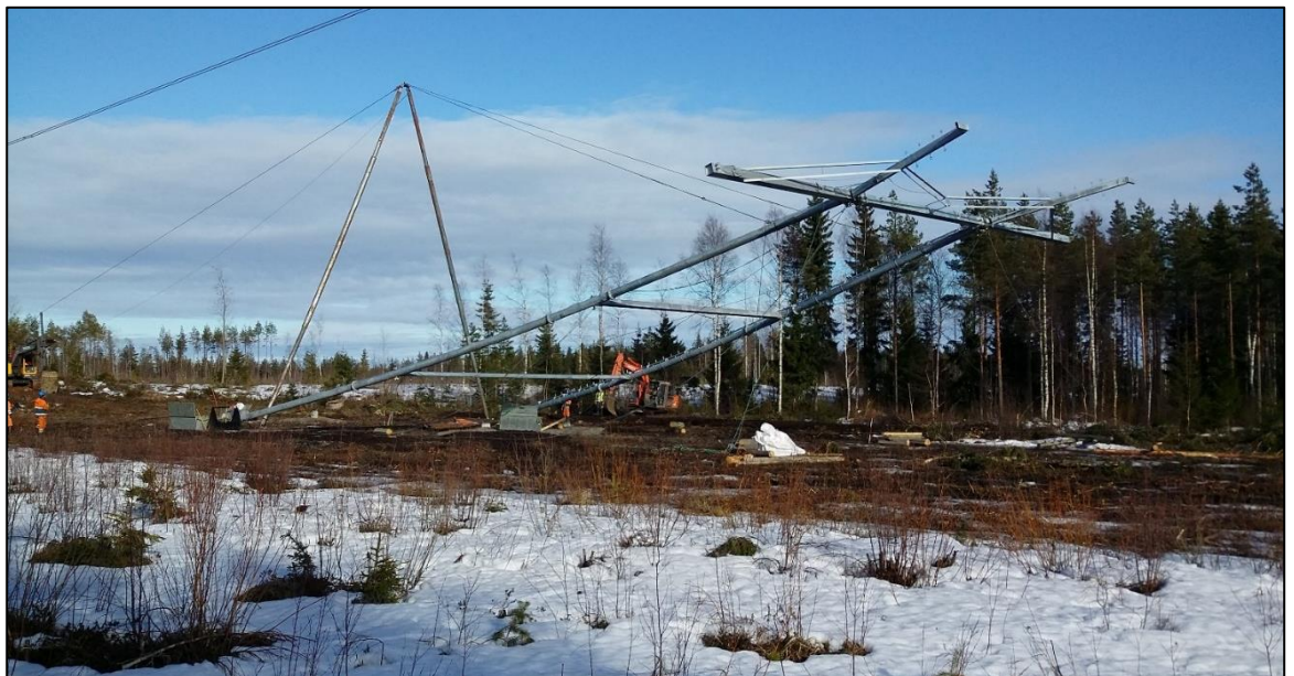
Kuva 3.6. Voimajohtopylvään pystytys.
