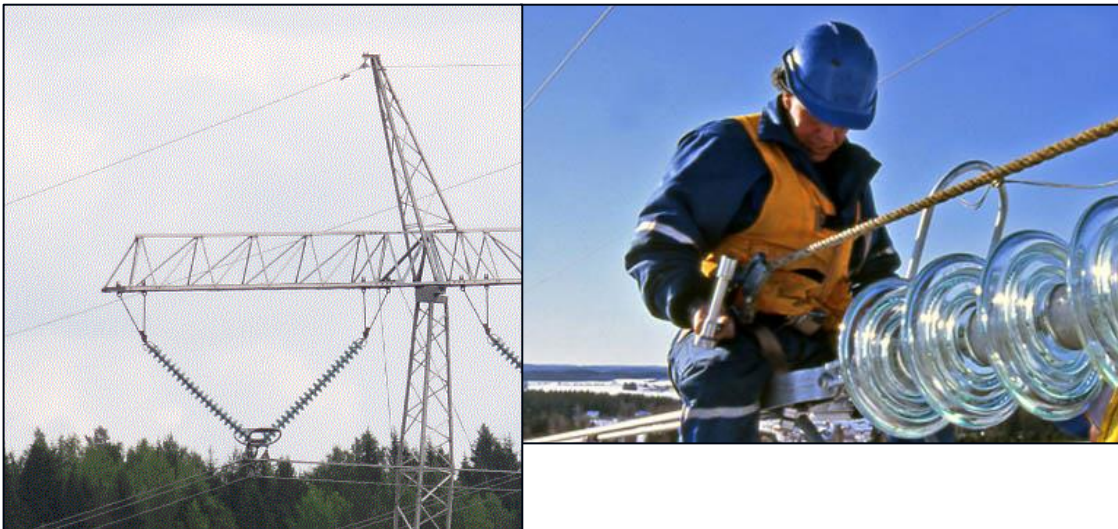
Kuva 6.4. Voimajohtopylvään eristimiä, joissa koronapurkauksia voi esiintyä.
