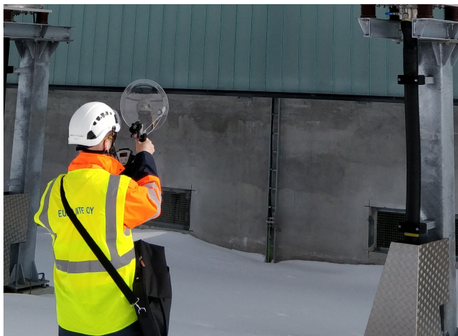
Kuva 14. PD-mittaus Baur PD-SGS osittaispurkausmittarilla parabolisella peilillä.
