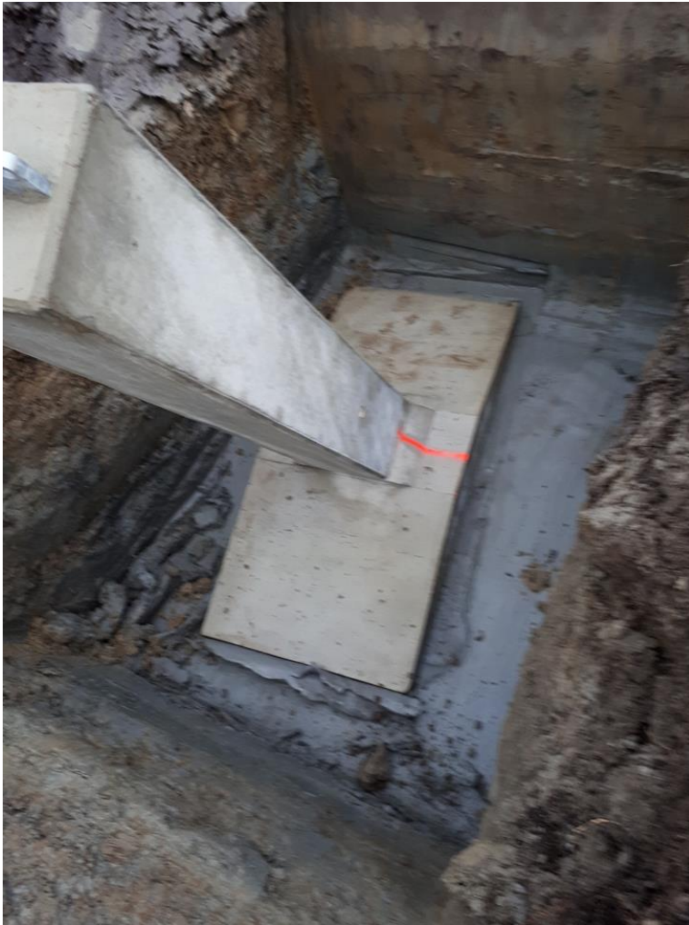
Kuva 5.4. Perustuksen PH2200/II asennus.
