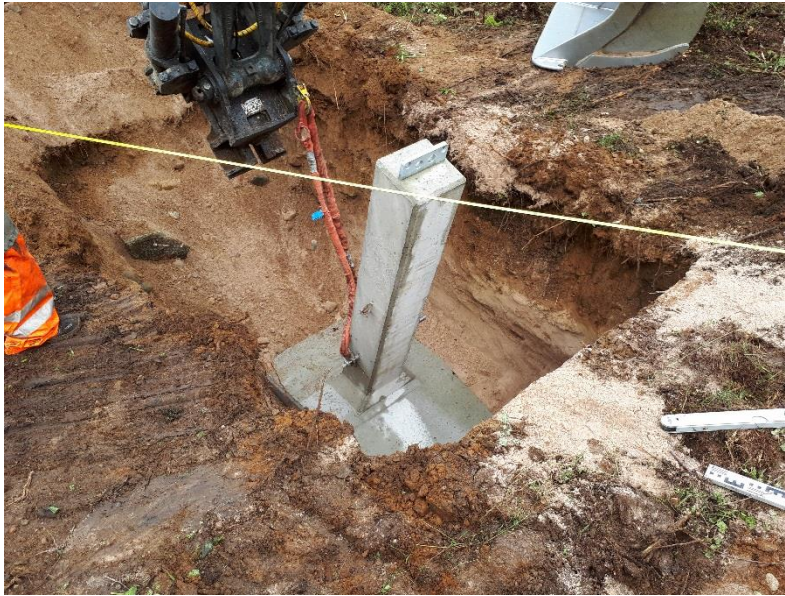
Kuva 2.5. Pilariharusankkurin paikalleenmittaus.
