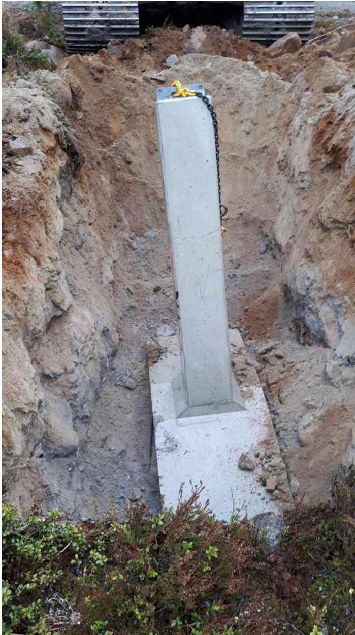
Kuva 5.7. Perustuksen PH2200/II asennus Vihtavuoressa.
