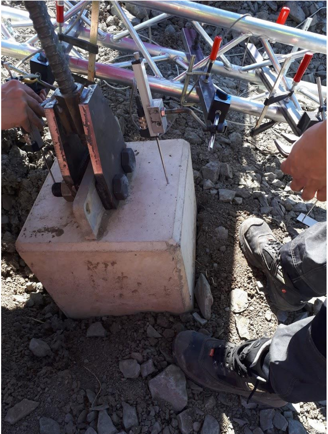
Kuva 5.10. Mittakellojen asennus pilariharusankkurin pilariosaan.
