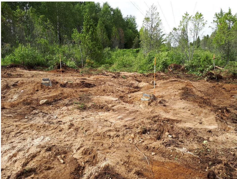
Kuva 2.7. Pilariharusankkurit perustettu.
