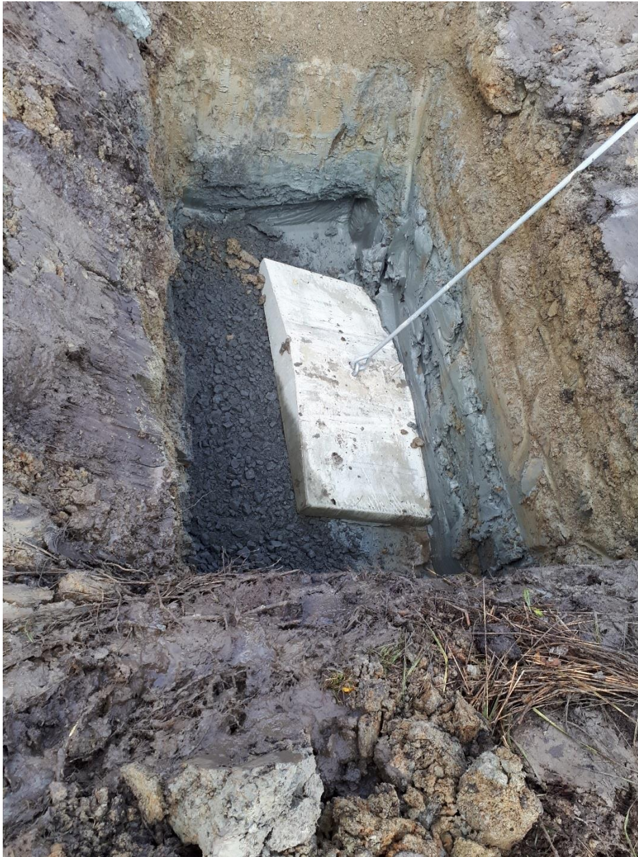
Kuva 2.6. Haruslaatan asennus Lavianvuorella.
