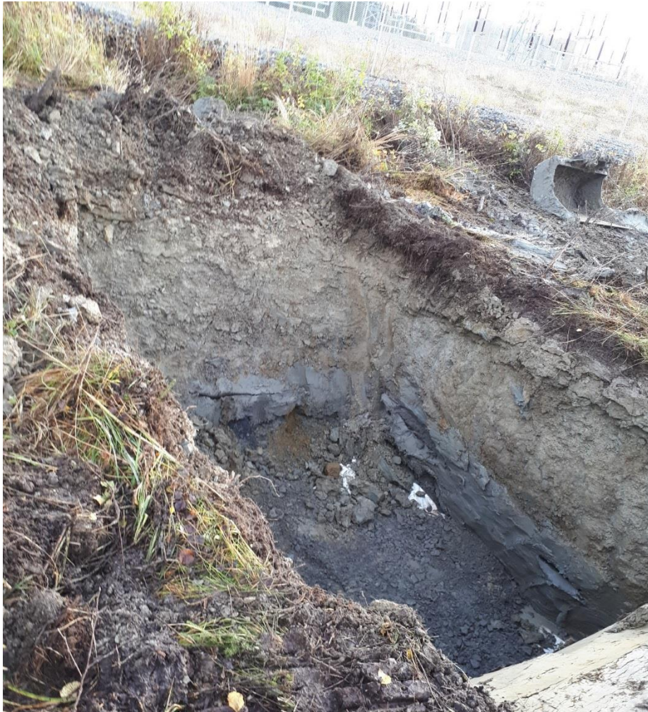
Kuva 5.5. Perustuksen PH2400/II kaivannon pohja tasattiin murskeella.
