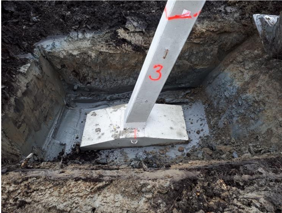
Kuva 5.3. Perustuksen PH2200/III asennus Lavianvuorella.
