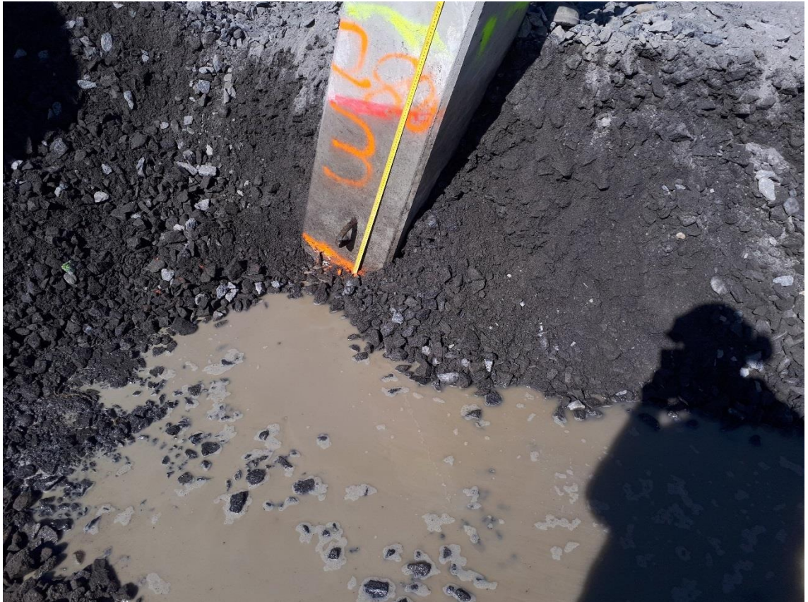
Kuva 5.6. Pohjavedenpinnan tason arviointi perustuksen PH2800/I aukikaivuun yhteydessä.
