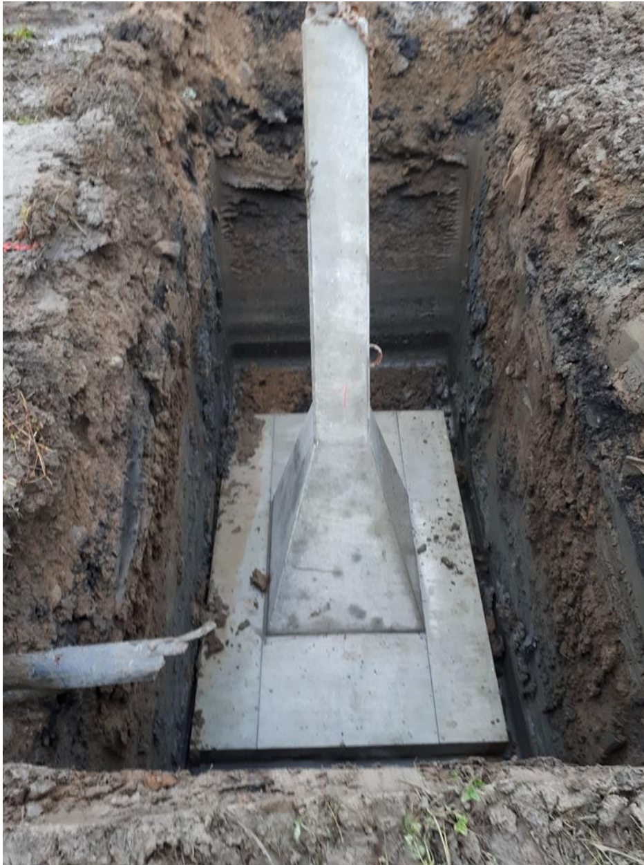
Kuva 5.1. Perustusten PH2400/II asennus Forssassa.
