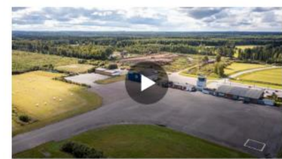
Joroisten lentokentälle rakennetaan aurinkosähköpuistoa. Suomeen on tulossa lähivuosina useita suuria aurinkopuistoja, suurimpen teho vastaa ydinvoimalasta.
