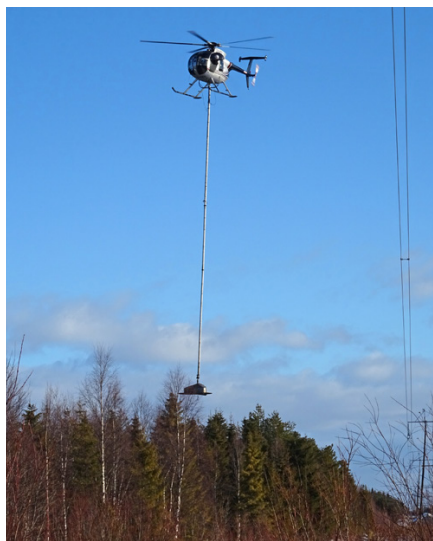
Bild 4. Helikopterkapning av träd är en bra metod, då bara en del av träden kräver kapning.
